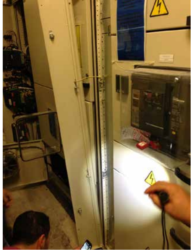
Fotoğraf 7 – Etiketleme, kilitleme uygulanan enerjili panel
