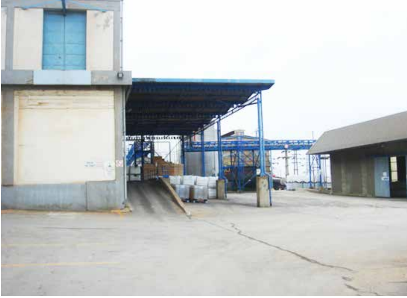
Resim 12- Forklift operatörünün kaza yaptığı yerde kaza yerinin görünüşü.
