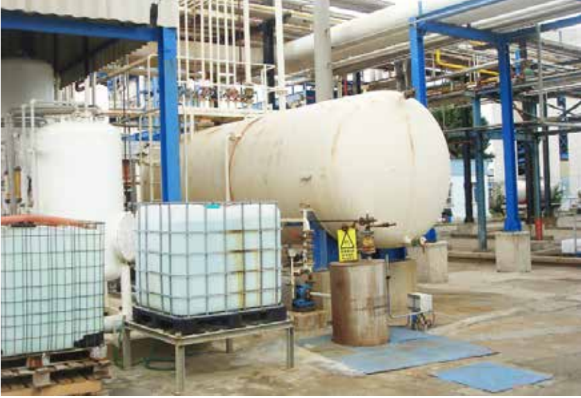
Resim 9 : E.T.'nin bacalarının yanmasına neden olan tank önündeki -ağız kapalı- rögar.
